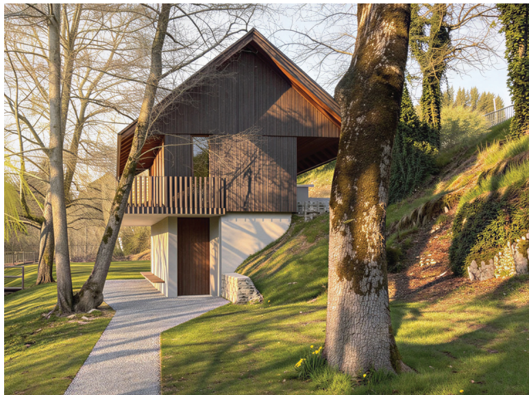
NOV OBJEKT SANITARIJ (AVTOR: ATERIERARHITEKTI)
